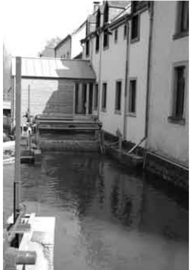
Einlaufkanal zur Turbinenkammer, mit Feinrechen und Kettenrechenreiniger
