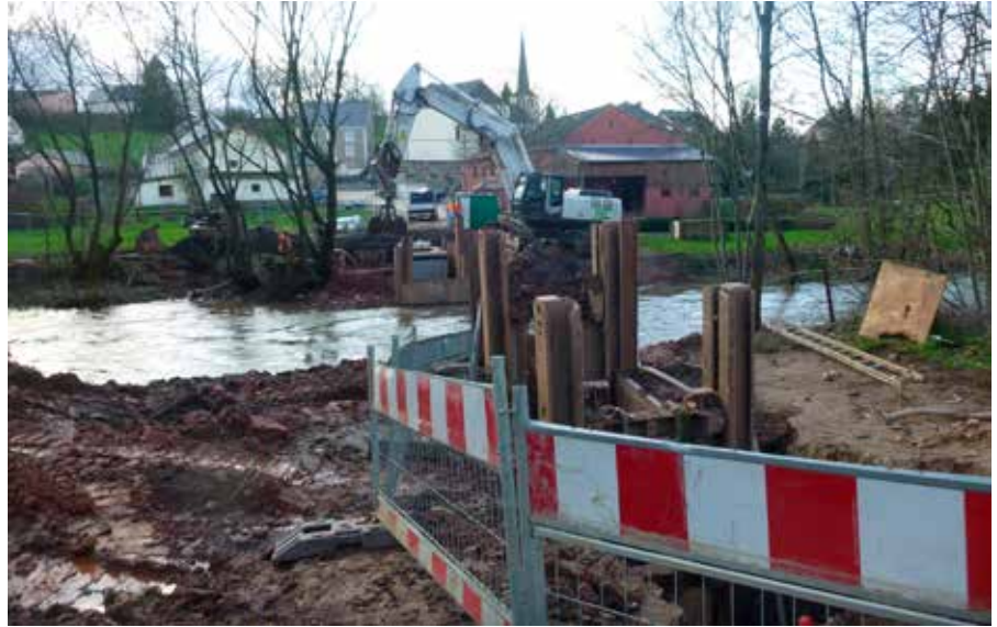
Traversée vum Kanal duerch d'Atert a Virbereedungsarbeiten am Eck
