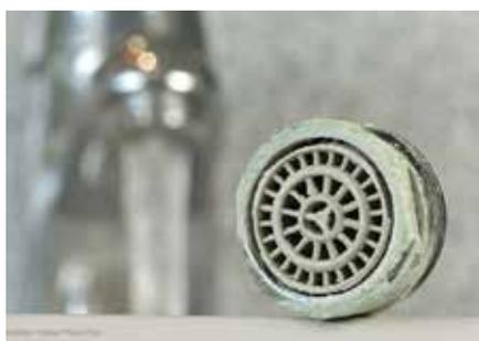
Minifontänen am Brauseschlauch, tropfende Wasserhähne und undichte Spülkästen verschwenden literweise Wasser. Schuld sind meist poröse oder verkalkte Dichtungen. Ersatz gibt es für kleines Geld im Baumarkt oder Fachhandel. Gegen den Kalk hilft Essigreiniger. Bei undichten Stöpseln für den Abfluss hilft Alleskleber: auf den Rand auftragen, vor dem nächsten Einsatz trocknen lassen und so den Stöpsel etwas verbreitern.
