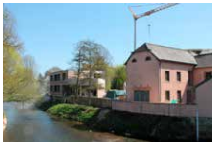
Lenks op der Foto: Gîte touristique; riets op der Foto: Tannerie, Bannenhaff mat der Terrasse vun der Brasserie
