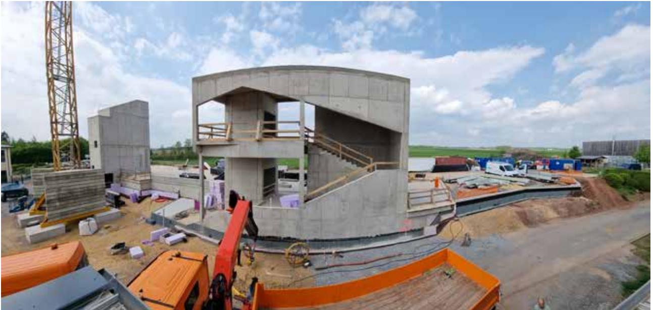
vum Chantier vun der Erweiterung vun der Schoul
