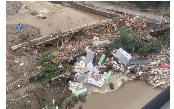
Verklauste Brücke an der Ahr im Juli 2021 (Foto: Schüller)
