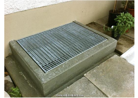
Erhöhter Lichtschacht (Quelle: Wikipedia)
